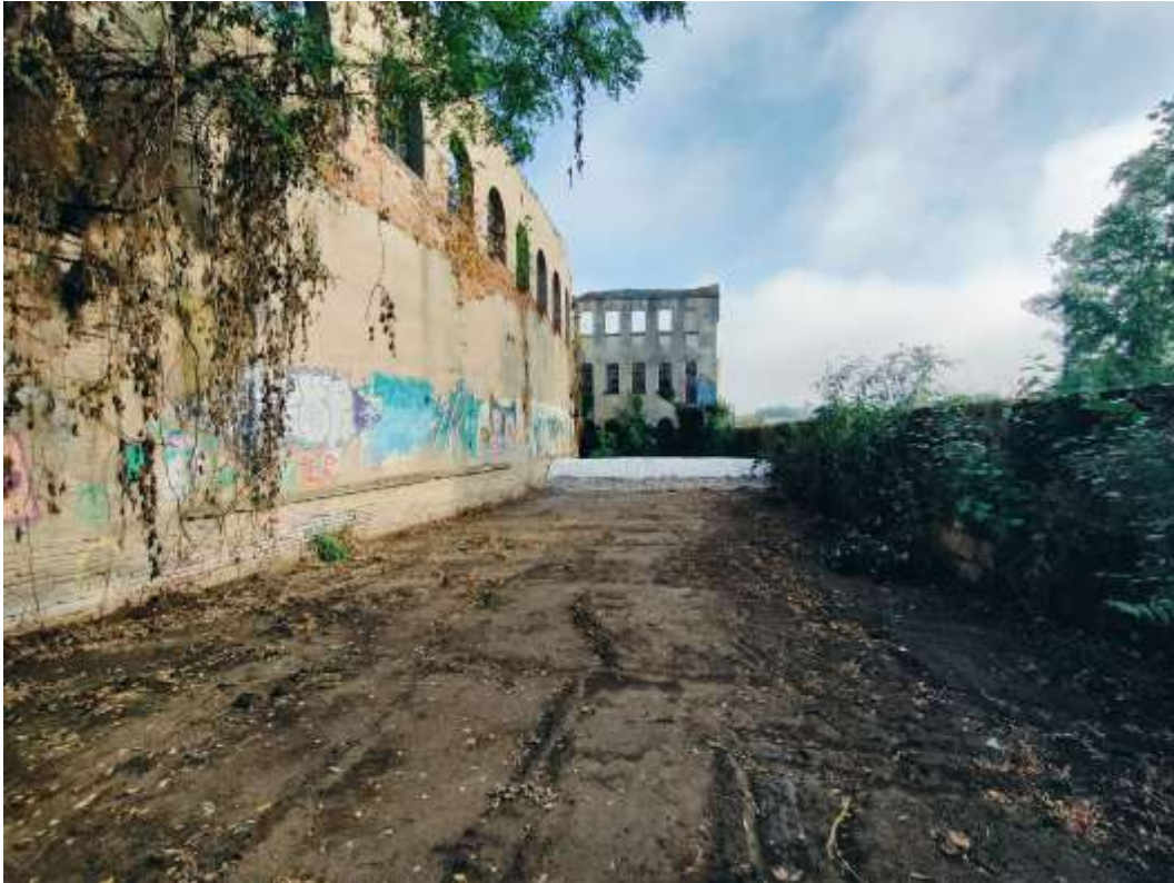
Figure 12 : Photographie bassin de décantation réalisé en 2023 (merlon granulaire filtrant)
